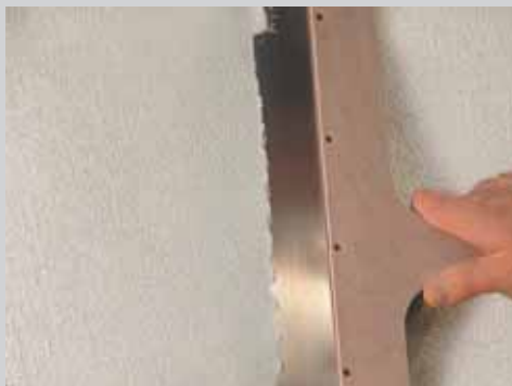
3 Dressage de l'enduit
